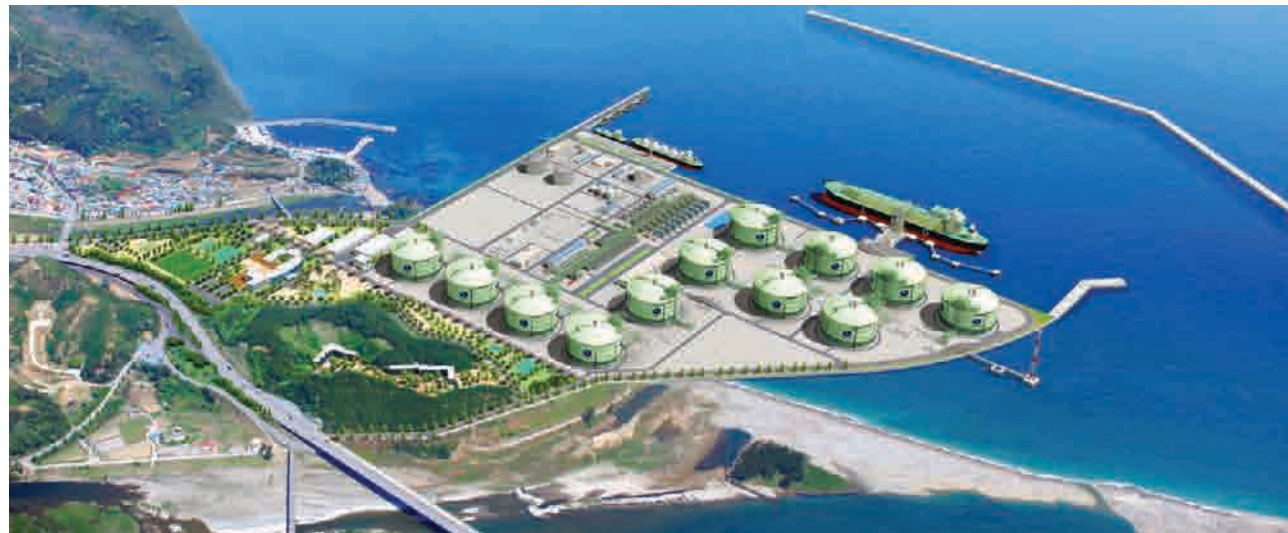
Samcheok LNG Plant No. 1 - 4 • Location : Samcheok, Gangwon-do • Client : Korea Gas Corp. • Project Overview : LNG Storage Tank 200,000 kl x 4units
